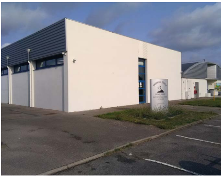
Ravalement de façade du dojo - complexe René Durel
