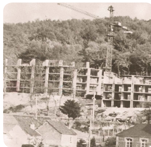
construction du "foyer-logement", aujourd'hui EHPAD ©R.Houdin
