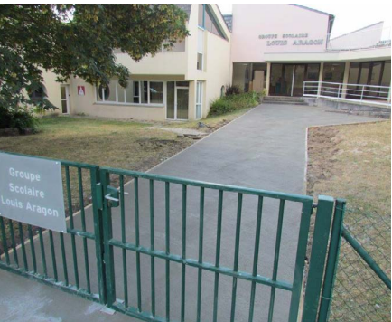
Rénovation de l'allée du groupe scolaire et pose d'un jeu
